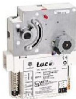
Controllore DDC configurabile, certificato LonMark®, per unità terminali VAV con una o due stadi di riscaldamento. Integra, in una periferica compatta, una trasduttore statico di velocità dell'aria ed un attuatore bidirezionale motorizzato. Può essere utilizzato come unità stand-alone o integrato in reti LonWorks® Vista®. Supporta i moduli STR per il controllo dei setpoint e delle variabili d'ambiente.
